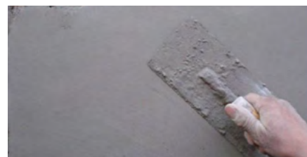
Preparación de paredes con MAGH
