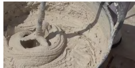
Mezcla del adhesivo
