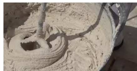
Mezcla del adhesivo
